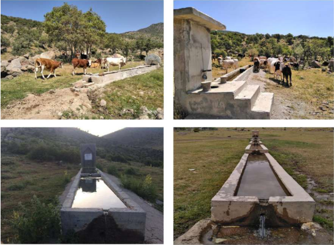
Şekil 4. Farklı Şekillerde İnşa Edilmiş Çoban Çeşmeleri (Org.)
