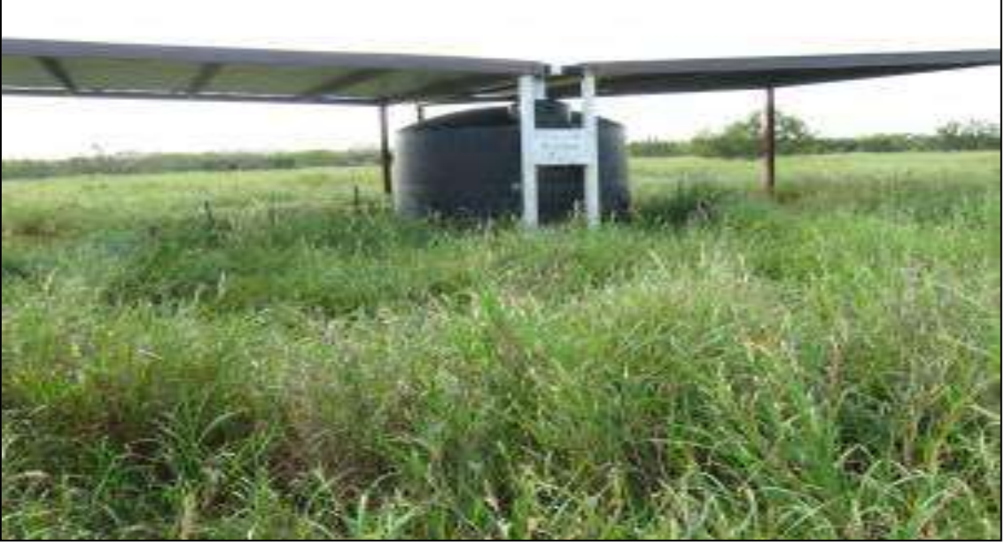
Şekil 12. Merada yağmur sularının depolanmasını da sağlayan gölgelik modeli
