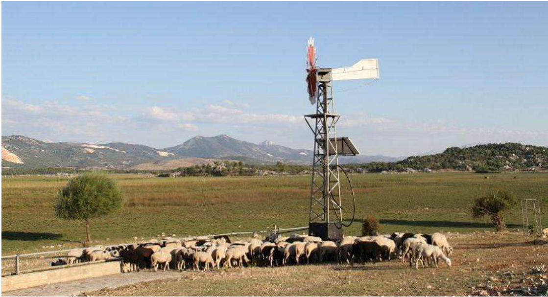
Şekil 9. Rüzgar hemde güneş enerjisi ile çalışan hayvan sulama kuyusu (Org.)
